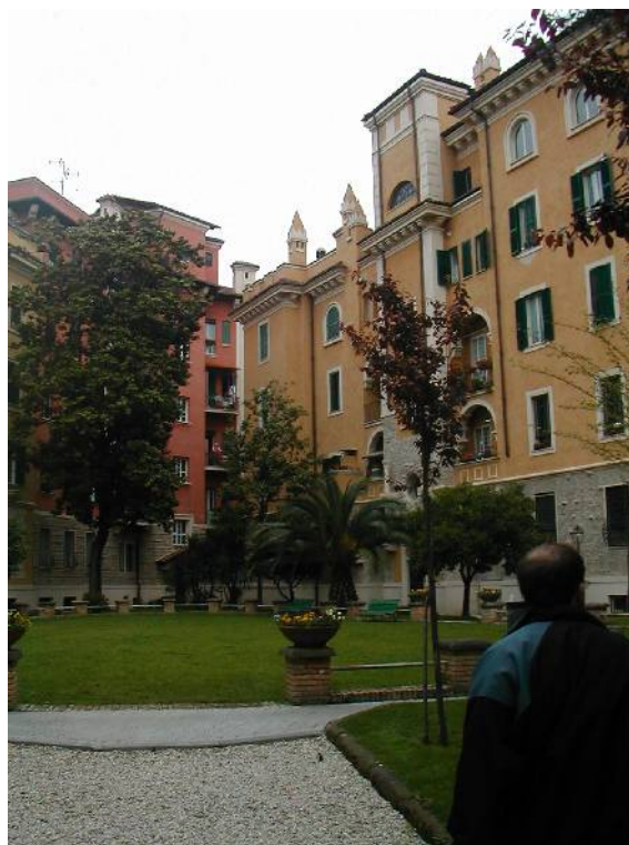
Camillo Palmerini, Complesso ICP di Piazza Tuscolo.
