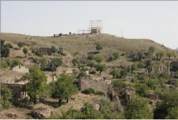
In alto, sullo sfondo, il cantiere della chiesa, in primo piano le rovine del villaggio che sta già rinascendo.
