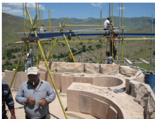
Costruzione della nuova Chiesa Armena di San Giovanni Battista, in muratura a emplekton sostanzialmente identica all'antica muratura del Ninfeo di Letoon, Xanthus.
