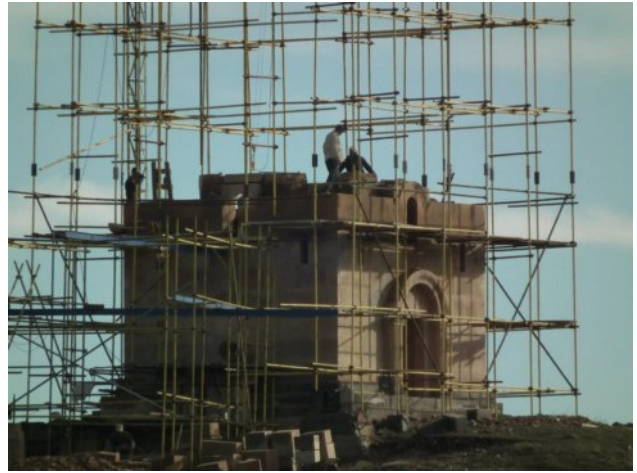
Gli operai lavorano alle coperture del raccordo al tamburo ottagonale, mentre il portale è già completo
