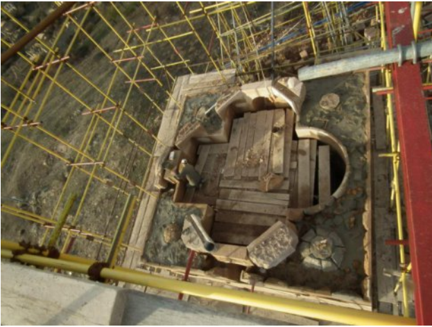
Copertura del primo livello; negli angoli si nota l'estradosso delle cupolette laterali.
