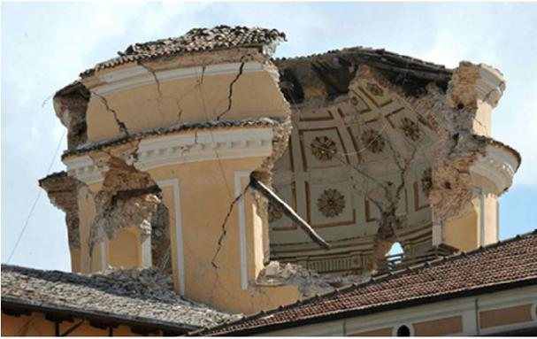
La cupola della Chiesa delle Anime Sante di L'Aquila dopo il crollo generato dal sovraccarico e irrigidimento delle strutture operato in fase di restauro: si noti che lo squarcio nelle murature ha evidenziato la presenza delle catene in legno impiegate dal Valadier nella costruzione ... tecnica totalmente ignorata dai recenti "restauratori".
