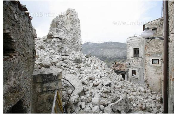
Il crollo della Torre Medicea di Santo Stefano in Sessanio, causato dalla sostituzione – da parte della Soprintendenza – dei solai originali in legno con strutture latero-cementizie: gli edifici circostanti, sui quali la soprintendenza non ha operato, sono rimasti praticamente illesi dal sisma grazie al loro restauro privato in tecnica tradizionale.
